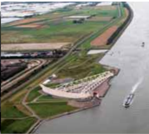
bovenaanzicht Maeslantkering Foto: Rijkswaterstaat
